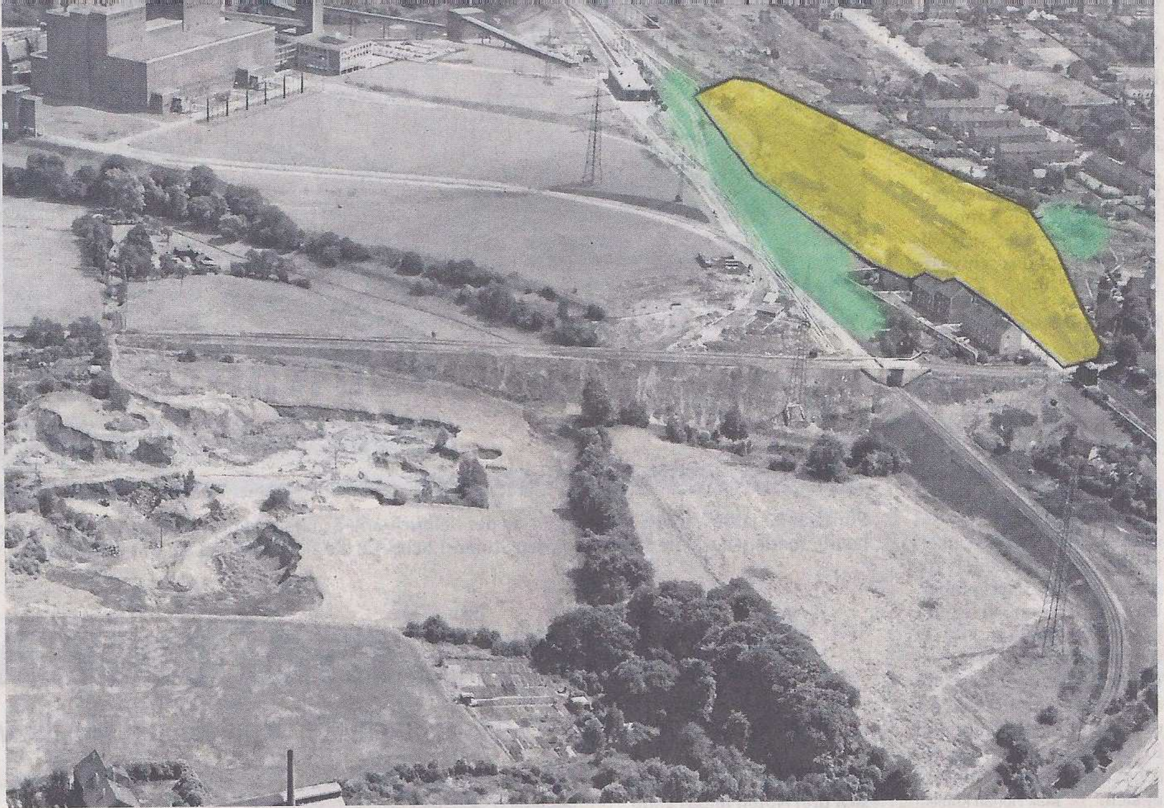
Heute müssten für die geplanten Häuser Bäume weichen. 1963 lagen auf dem betreffenden Gelände (grün markierter Bereich) Gleise. Ob der gewachsene Wald auch wirklich einer ist, das muss die Untere Forstbehörde entscheiden. Foto Presseamt Stadt Bochum
